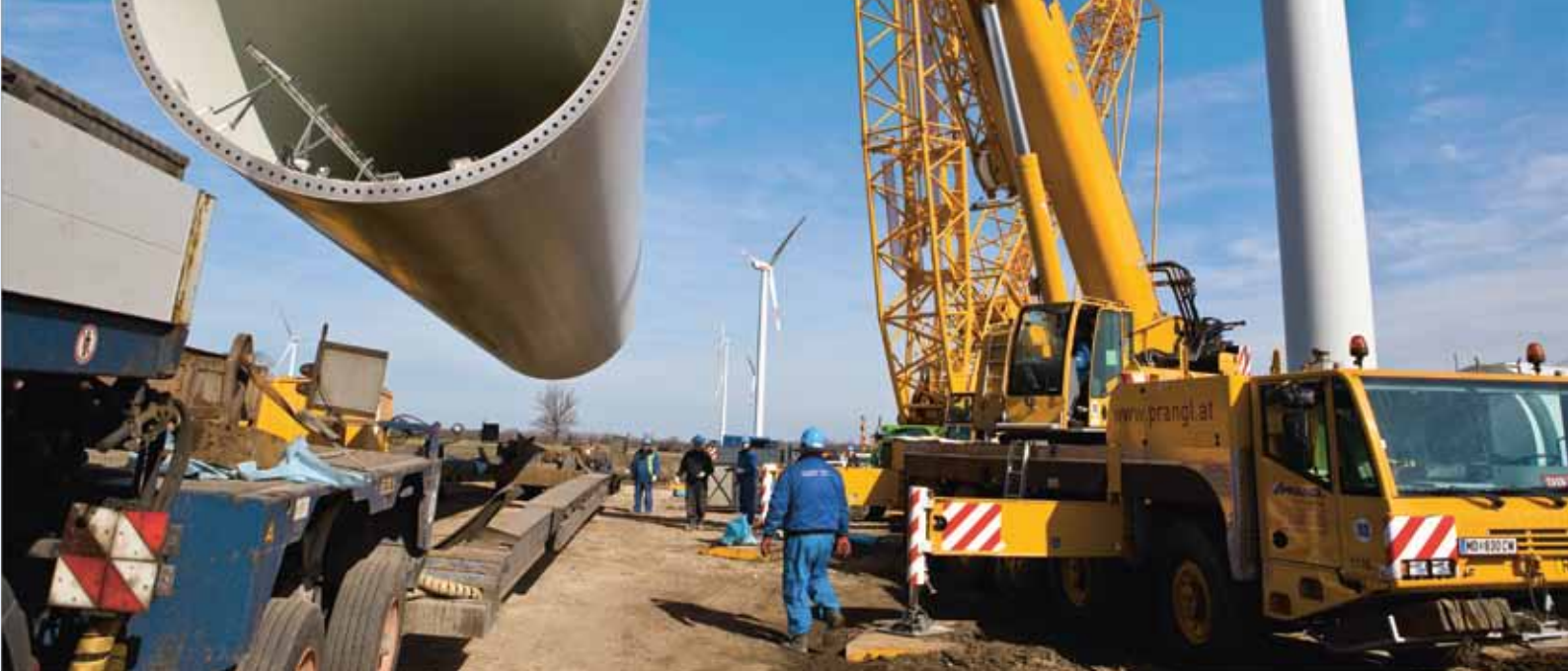
Errichtung der Windkraftanlage in Levél (1. Ausbaustufe)
