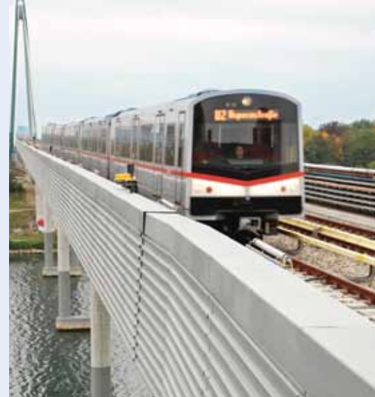
U2 auf der neuen Strecke bis Aspernstraße
