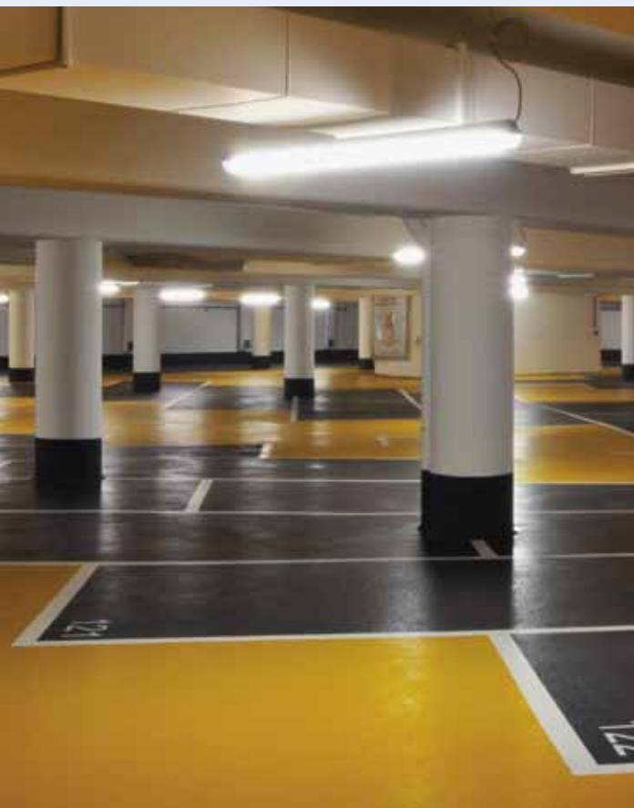
Garage Beethovenplatz nach der Modernisierung
