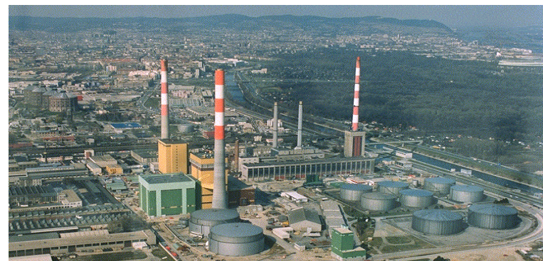
2 Kombikraftwerke: 2 x 380 MW Strom + 280 MW bzw. 350 MW Fernwärme
