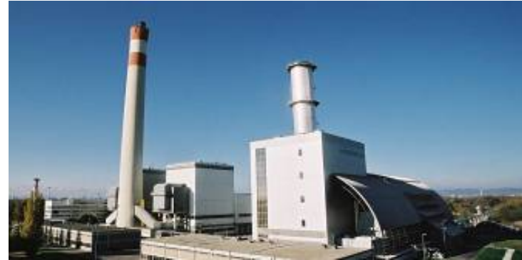
1 Dampfkraftwerk: 162 MW Strom 1 Gas- und Dampfturbinenkraftwerk: 380 MW Strom + 250 MW Fernwärme
