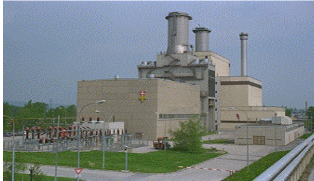
Gas- und Dampfturbinenkraftwerk: 150 MW Strom + 170 MW Fernwärme
