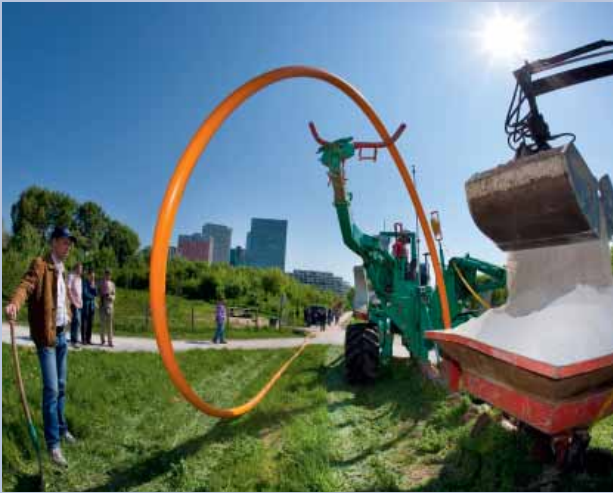
Ausbau der Versorgungsnetze: Gasrohrverlegung mittels Pflug
