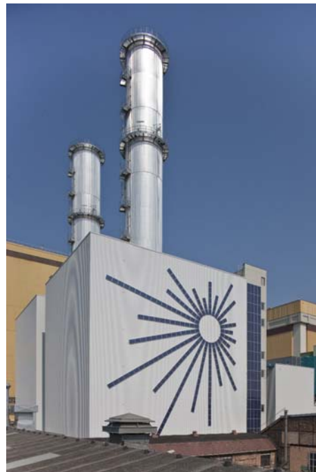
Abbildung 21: FV-Anlage an der Fassade des neuen Kraftwerks Simmering 1
